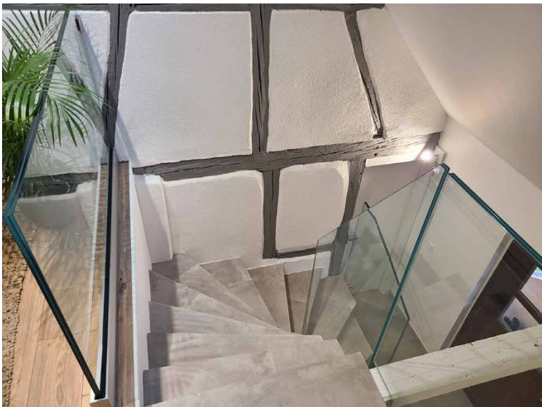
Garde-corps fixé sur rail
